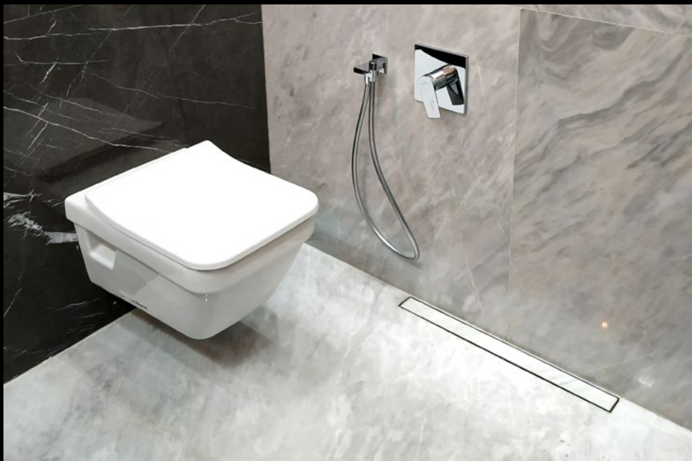
پروژه اجرا شده در سعادت آباد
