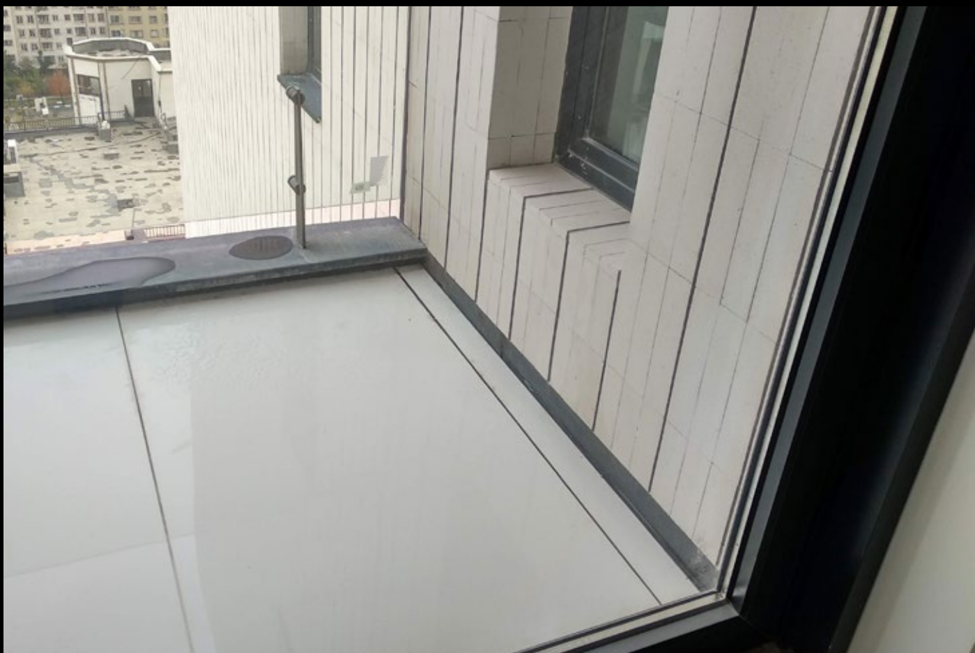
پروژه اجرا شده در سعادت آباد
